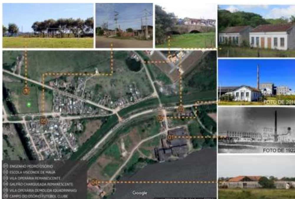
Figura 1 – Distribuição das edificações no espaço do Passo dos Negros.
